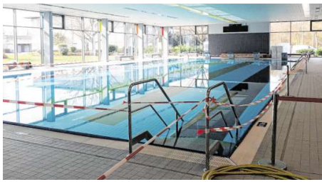
Seit einigen Tagen sind die Becken in der bereits 2016 sanierten Schwimmhalle wieder mit Wasser gefüllt. Hallenbad-Fans müssen sich gleichwohl noch etwas gedulden.
